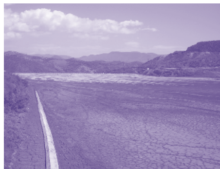
▲ Слева новое хвостохранилище, которое построил Deno Gold/Dundee, с замкнутым циклом водообеспечения — первое в своем роде в Армении.
