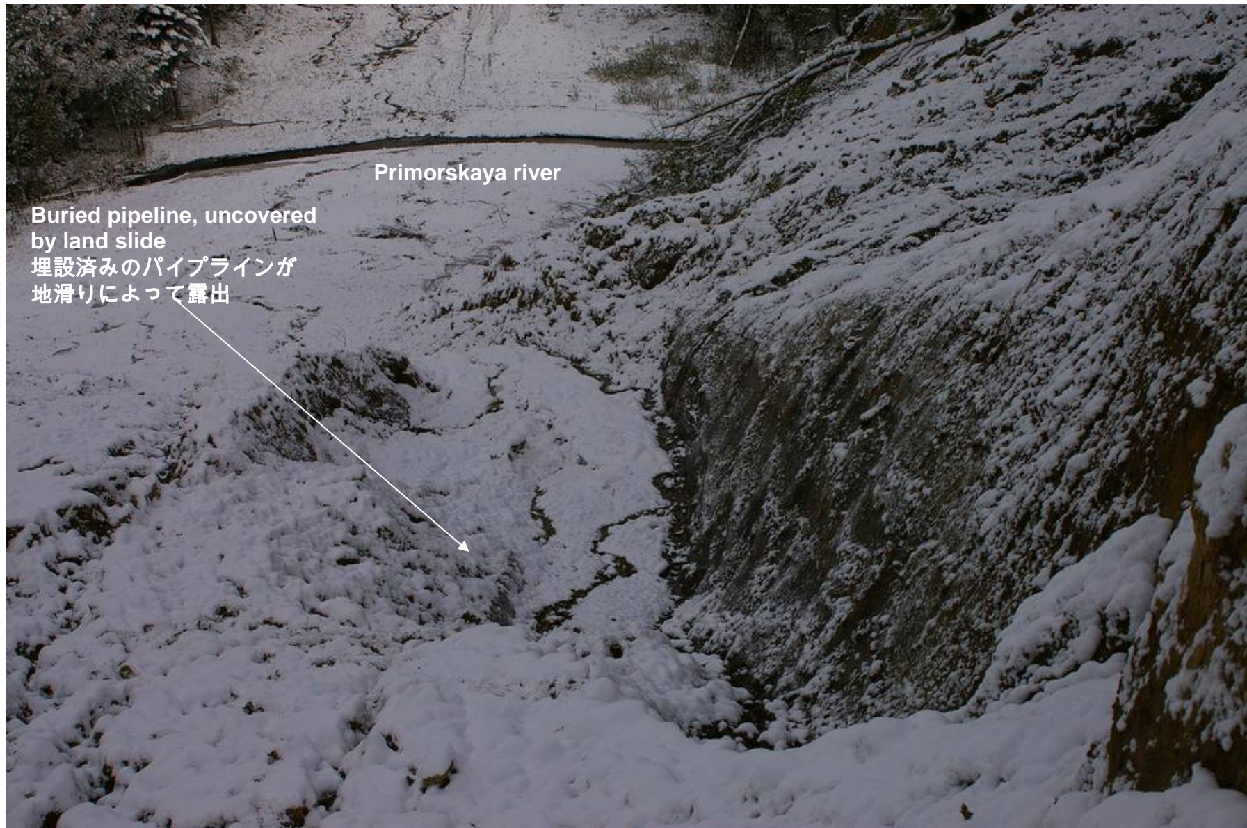
KP 482,6. Primorskaya川の右岸における最近の地滑り ( ドリンスク地区 ) KP 482,6. The fresh landslides on the right bank of the Primorskaya river, Dolinsk District.
