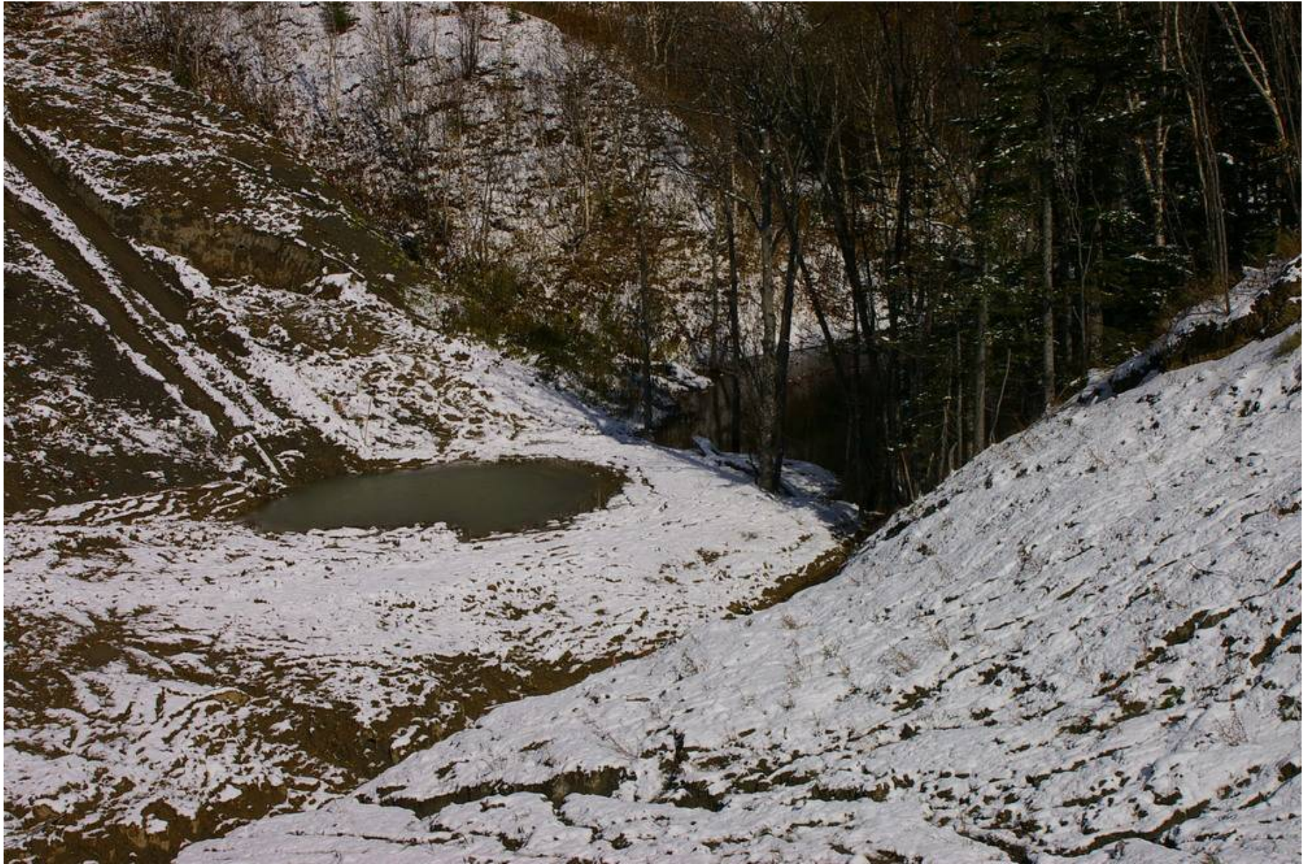
KP 462,6. Baklanovka川の左支流、右岸からの地滑り ( ドリンスク地区 ) さらに一ヶ月半後、改善なし。 No changed 1.5 months later else.
