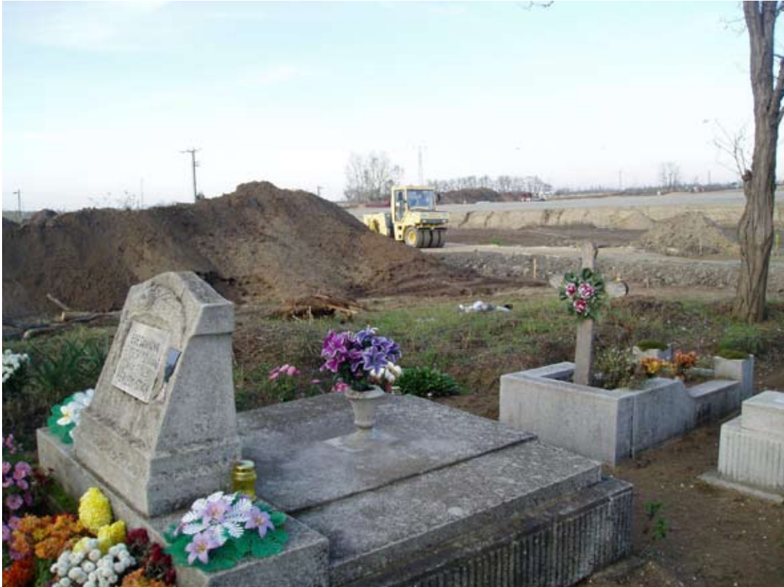
Mađarska autocesta M5, jedan od prvih JPP projekata u srednjoj i istočnoj Europi. Predviđena gustoća prometa nije ostvarena i država je morala otkupiti dio projekta te jamčiti prihode koncesionaru. Foto: CEE Bankwatch Network
