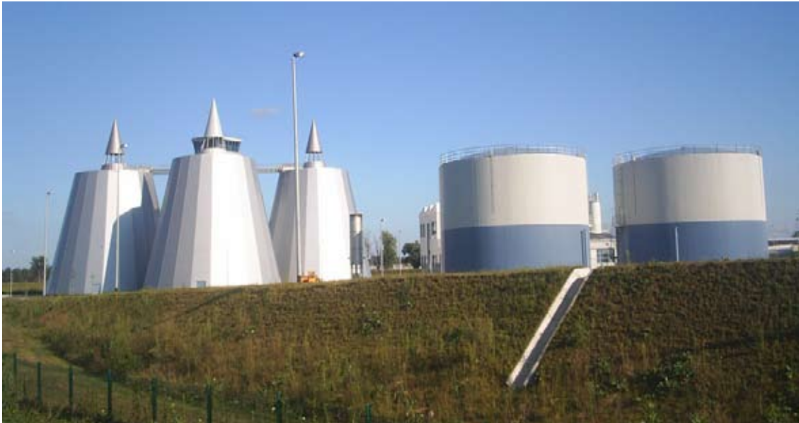
Zagrebački pročištač otpadnih voda bio je kritiziran zbog slabe vrijednosti za uloženi novac. Foto: UZOR
