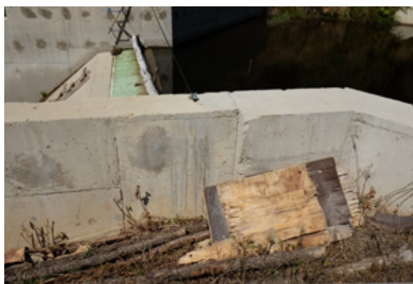
Слика 5: Предмет кој потенцијално се користи за блокирање на премиот за рибите на реката Станишар
