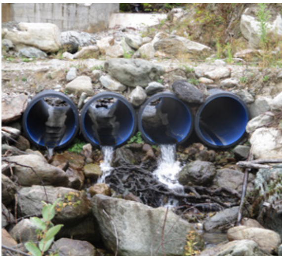
Слика 18: Подземен канал
