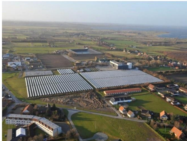
Fotografija: Sezonsko skladište u izgradnji i dopola ispunjeno vodom, snimak iz vazduha, izvor: PlanEnergi
