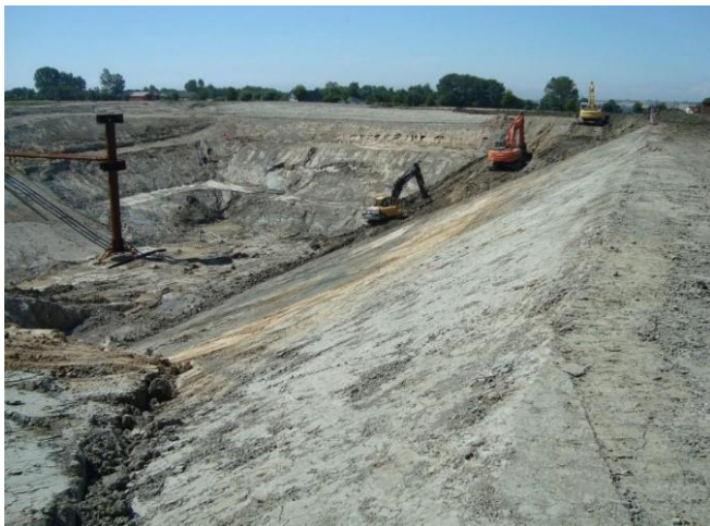
Fotografija: Sezonsko skladište u izgradnji i dopola ispunjeno vodom, snimak iz vazduha, izvor: PlanEnergi
