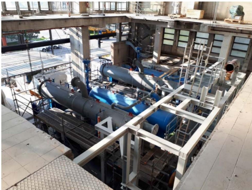
Slika 1: Prikaz velike toplotne pumpe u Wien Simmeringu (izvor Segala, 2018.) ©Wien Energie / Zinner
