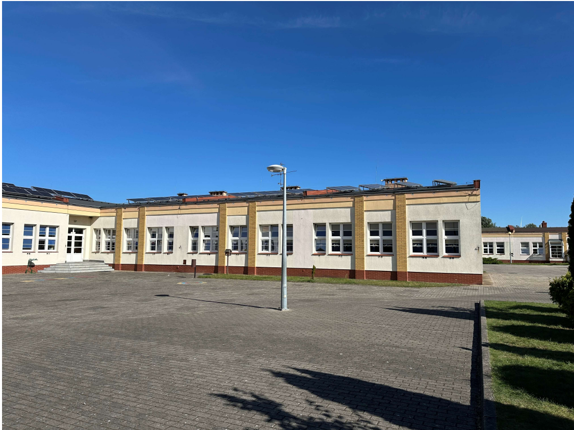
Fot. 3 Istniejąca instalacja fotowoltaiczna na dachu szkoły (autor Piotr Zaborowski)
