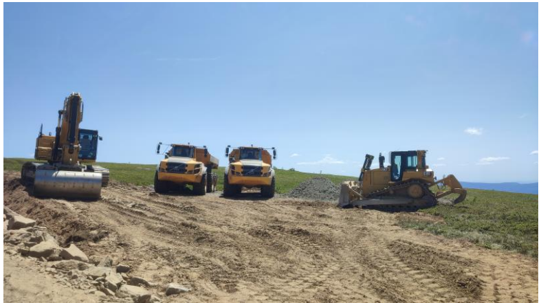
Будівельні роботи тривають на Полонині Руна, 21 червня 2025 року (фото: CEE Bankwatch Network).
